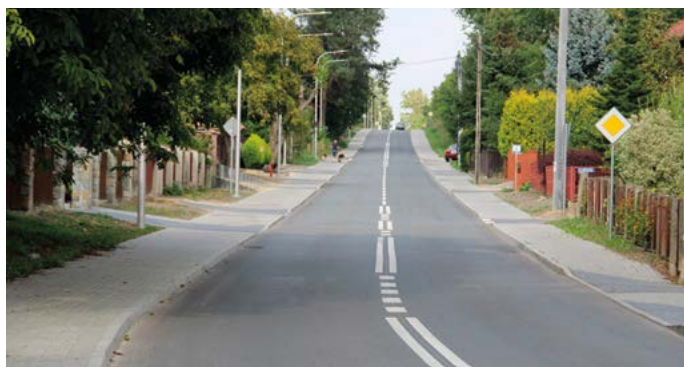
Przebudowa drogi Końskowola-Sielce
